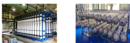
Công nghệ màng là giải pháp tiên tiến trong tái sử dụng nước thải, giúp loại bỏ tạp chất, vi khuẩn, virus và các chất ô nhiễm, đảm bảo nước đầu ra đạt tiêu chuẩn cao
